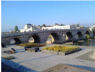
Слика 6. Камен мост 15
